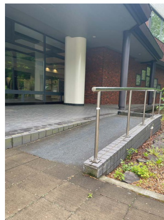
スロープの斜度 約5度 (幅120センチ)
