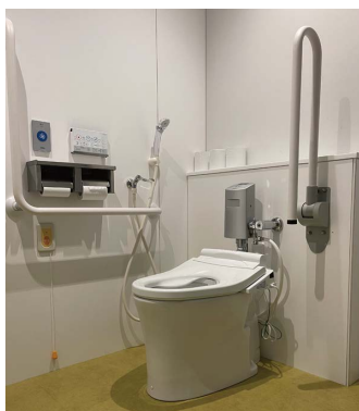
入口寸法 80センチ(扉は引き戸)
